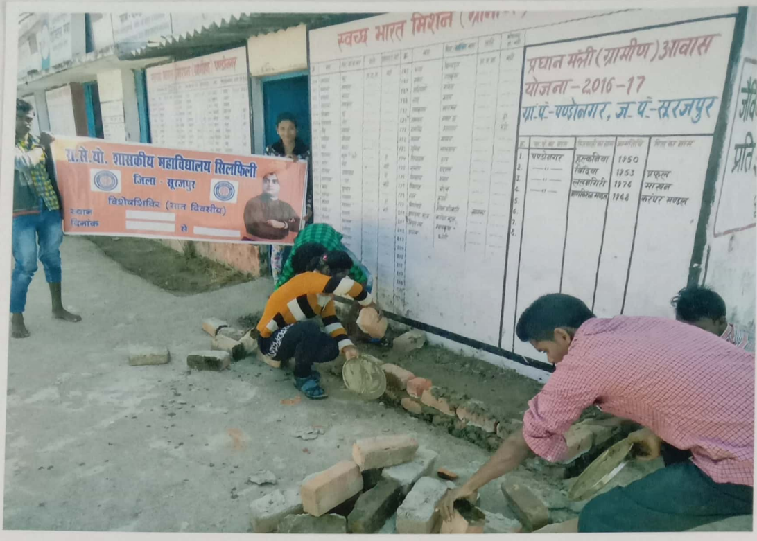
पंचायत भवन के पास कुड़ादान का निर्माण
